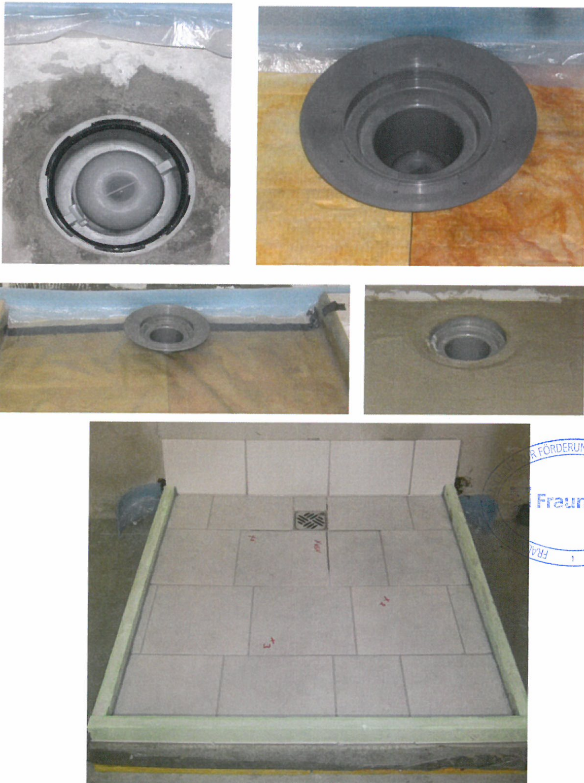
Bild 4 Oben links: Ablaufgrundkörper "Practicus" der Firma Kessel AG in Rohdecke einbetoniert. Oben rechts: "Variofix"-Dünnbettaufsatzstück der Firma Kessel AG Mitte links: MF-Trittschalldämmung auf der Rohdecke verlegt. Ablaufstutzen ausgespart. PE-Trennlage an Ablaufstutzen ausgeschnitten und vor Einbringen der Estrichmasse abgeklebt. Mitte rechts: Flansch des "Variofix"-Dünnbettaufsatzstück bündig mit Oberkante Estrich. Unten: Prüfaufbau im Prüfstand.
